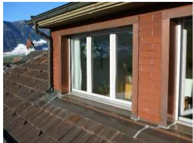
Spenglerarbeiten an Fensterrahmen im 3. OG Mythen
